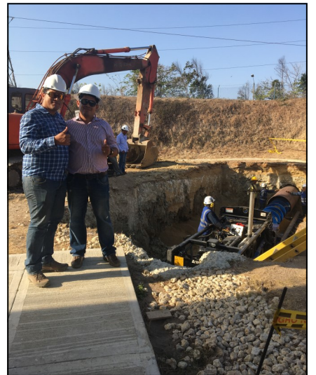
Instalación camisa de 36" sistema Auger Boring. ISA Transelca Barranquilla
