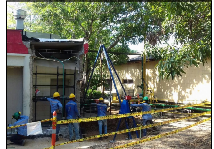
Pilotes Pre-excavados para Cafetería CABOT, DESCO.
