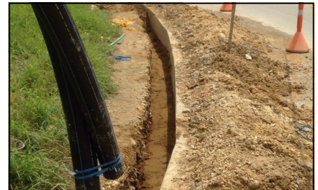
Instalación red de acueducto 4" PEAD - Multintegral.
